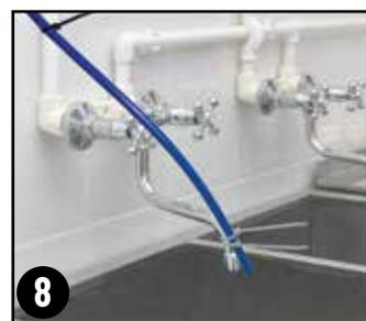
8. Dirija el otro extremo de la manguera **azul** de 3/8" que va AL TANQUE al fregadero o al desagüe.
